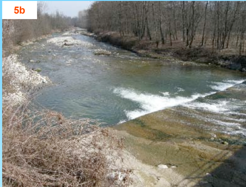
Briglia per protezione ponte su T. Brobbio
